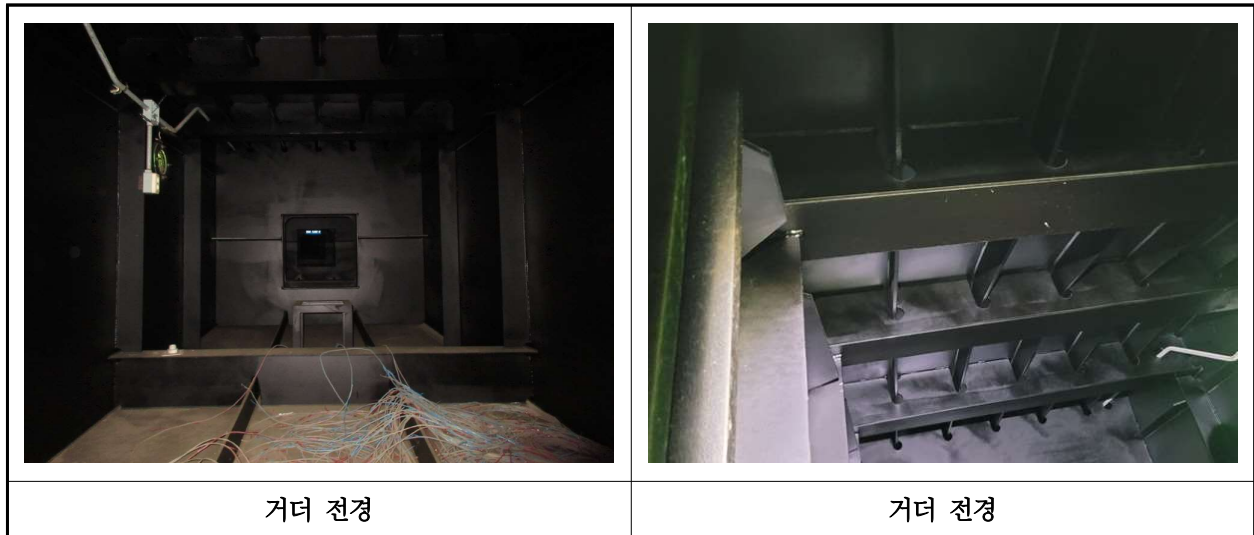
【사진 1.3.6】 거더 전경
