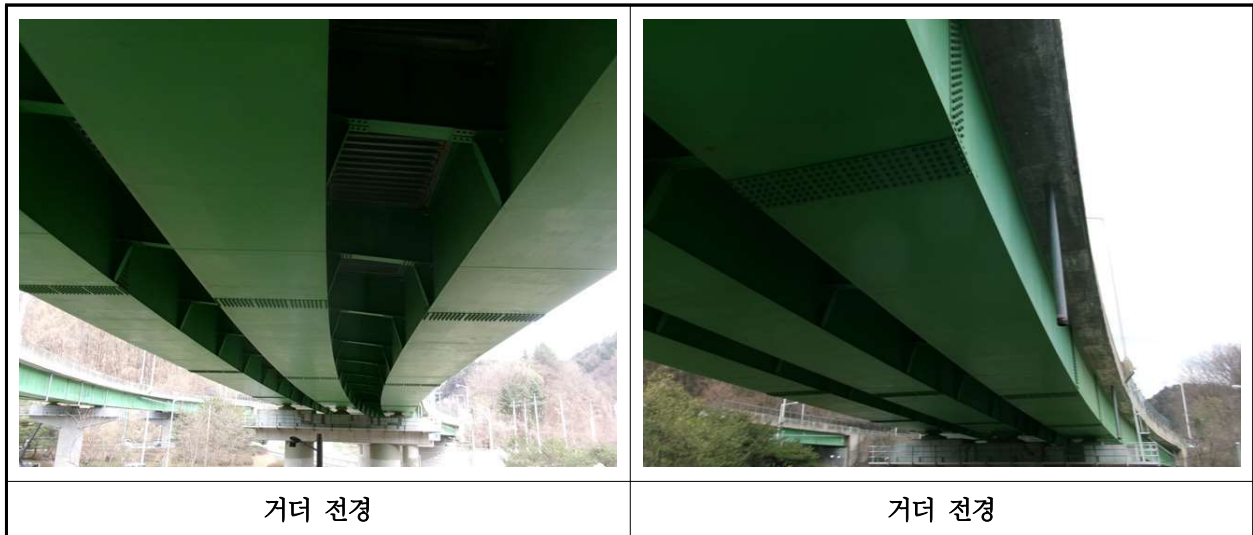
【사진 1.3.4】 거더 전경
