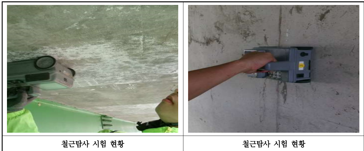
【사진 1.4.2】 철근탐사 시험
