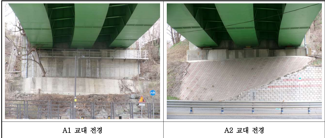
【사진 1.3.9】 교대 전경
