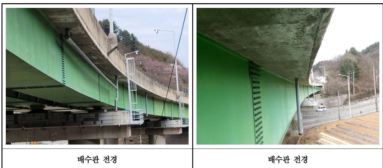
【사진 1.3.19】 배수시설 전경
