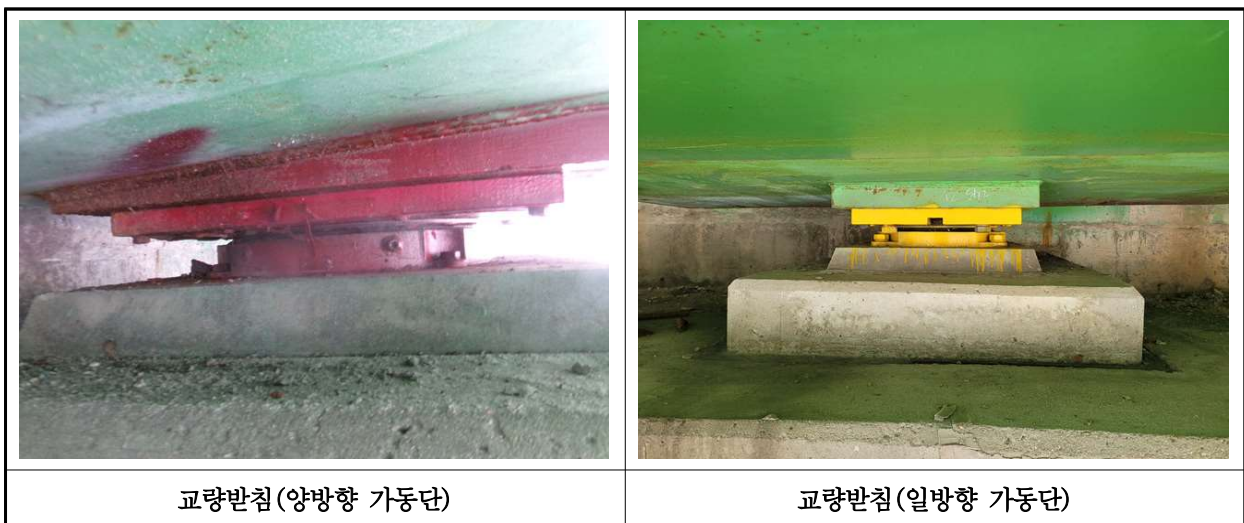
【사진 1.3.13】 교량받침 전경
