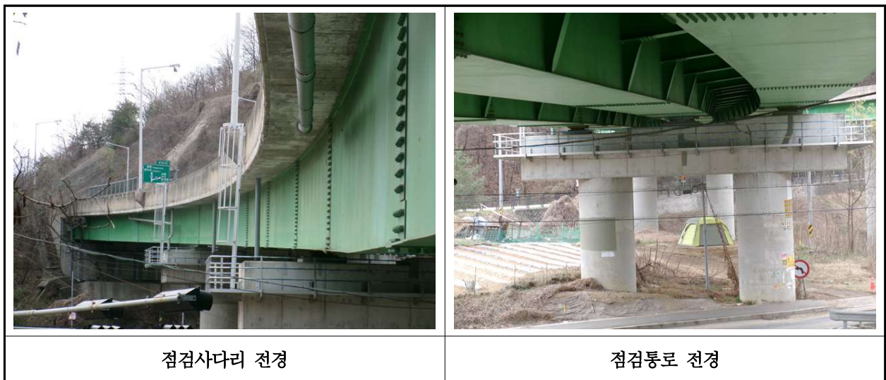
【사진 1.3.23】 교량 점검시설 전경
